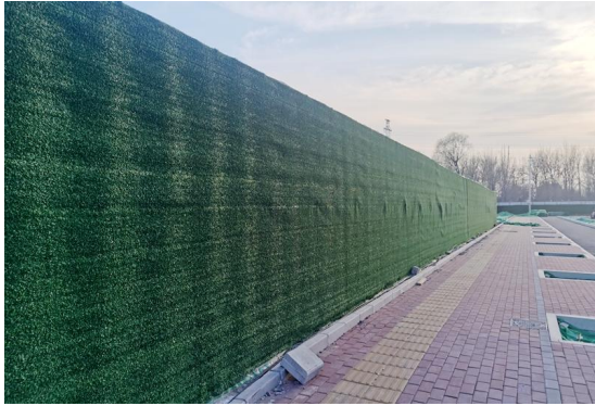
项目北侧围挡
