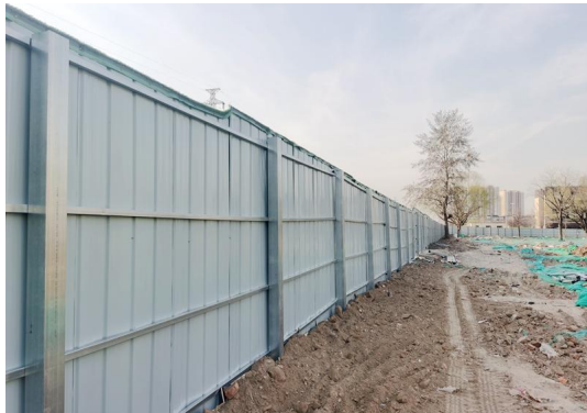
项目西侧围挡
